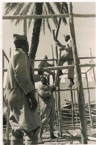
FIGURA 7. – Pabellón de Guinea. Construyendo la «casa palabra». Valencia, 1946. imagen cedida por Feria Valencia.
