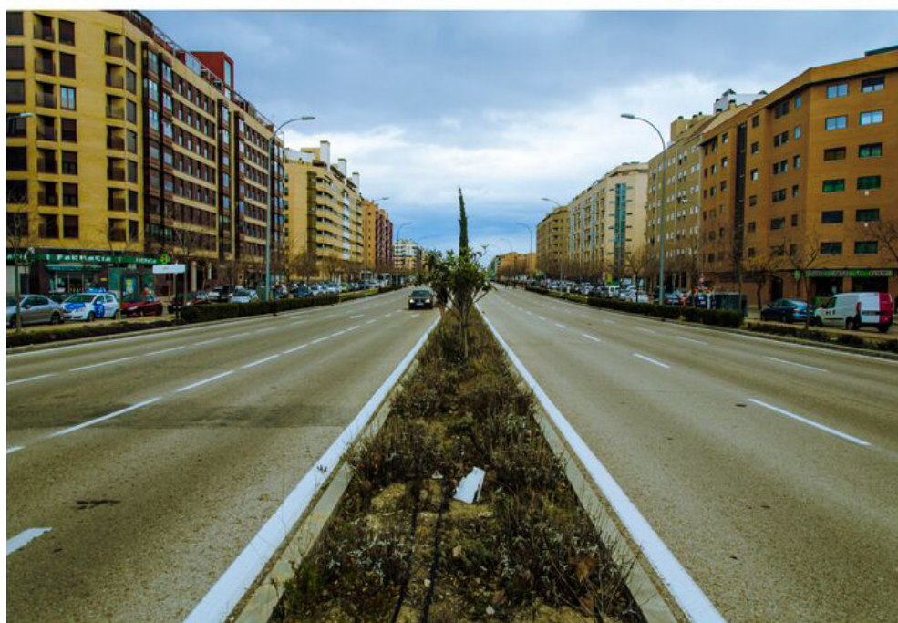
IMAGEN 1.—Arriba, el paseo Federico García Lorca de Villa de Vallecas. Abajo, la Avenida del Ensanche de Vallecas, vía principal del PAU.
