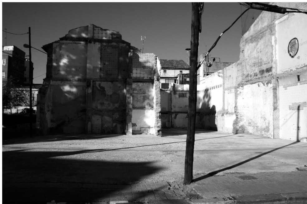
FIGURA 5.—Solar del Horno La Estrella (calle Escalante), derribado en abril del 2009. El edificio disponía de una típica torre-miramar del Cabanyal. 2010. Fotografía: Beatriz Santamarina.
