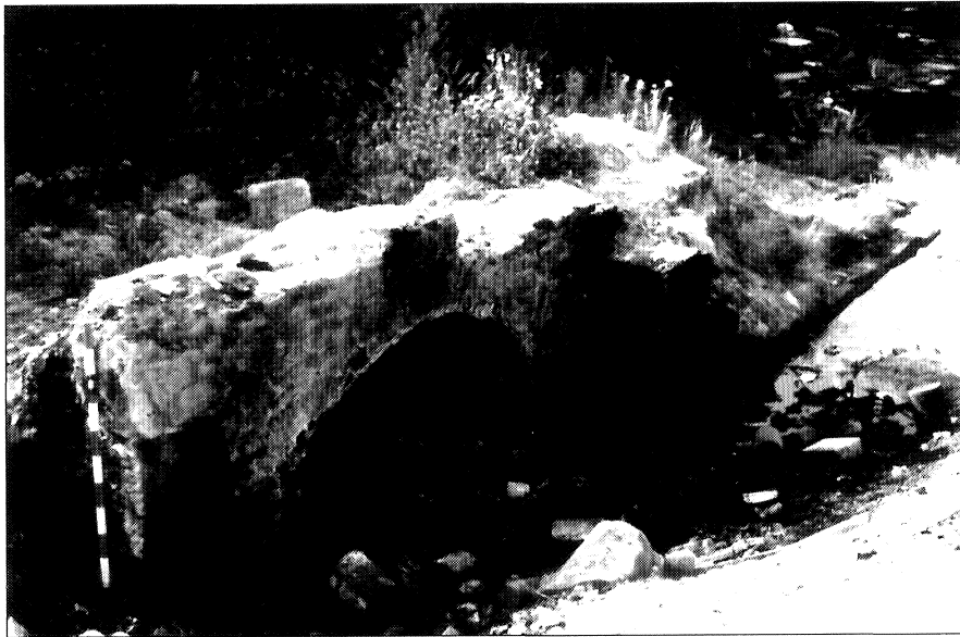
FIGURA 7.—Arcada y sillares a nivel de agua del Molino de la antigua Calle del Mar (Colindres).
